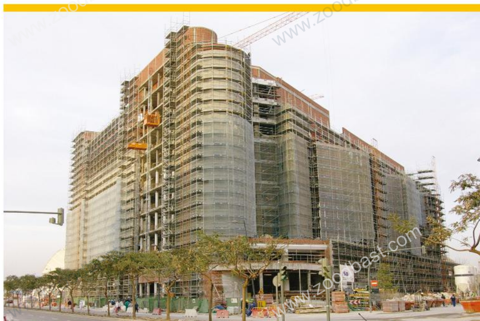
پوشش سطوح - نصب و اجرای نمای ساختمان
