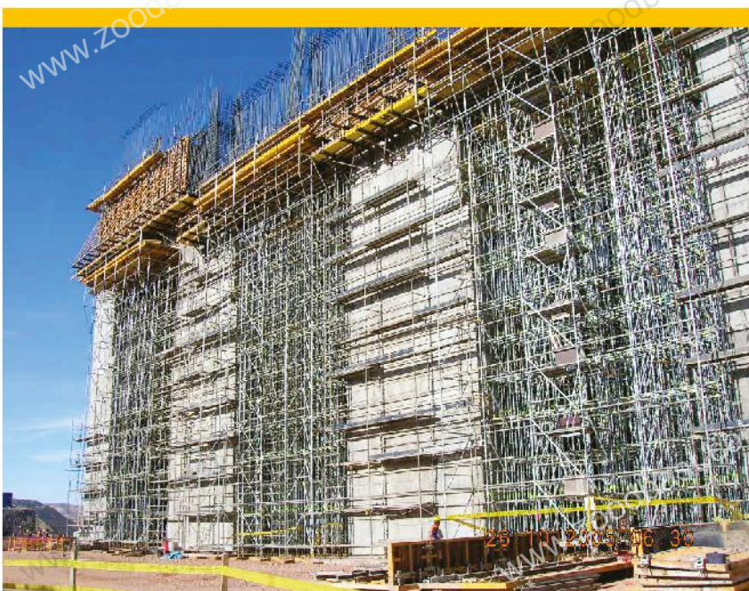
کفراژ بندی - اجرای سازه بتنی
