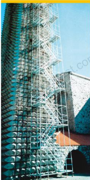
پلکان دسترسی - ساختمان های بلند
