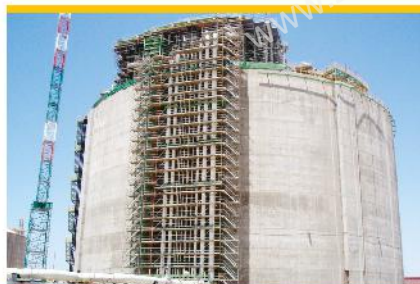
پلکان دسترسی - تأسیسات نفت و گاز
